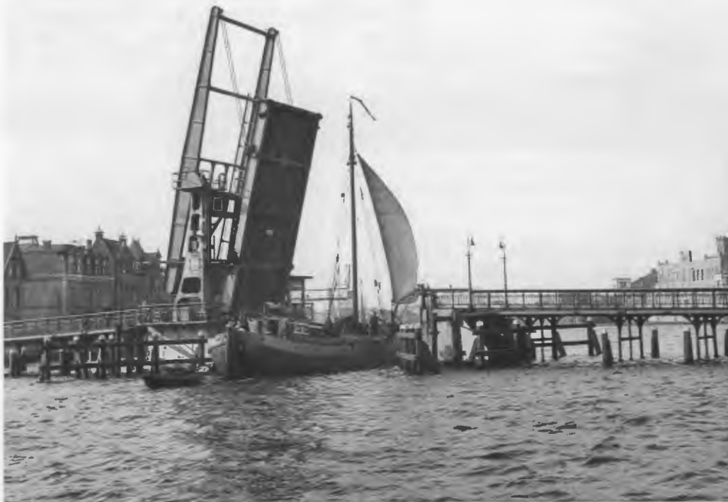
De Zaanbrug begin 30'er jaren nadat er een nieuwe klep was geplaatst. (coll. HVW)
